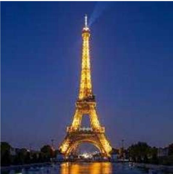
Pour la construction de la tour Eiffel, Gustave Eiffel avait utilisé 18 038 pièces métallique, 5 300 dessins d'atelier, 50 ingénieurs et dessinateurs, 150 ouvriers dans l'usine de Levallois-Perret, entre 150 et 300 ouvriers sur le chantier, 2 500 000 rivets, 7 300 tonnes de fer, 600 tonnes de peintures et 5 ascenseurs
